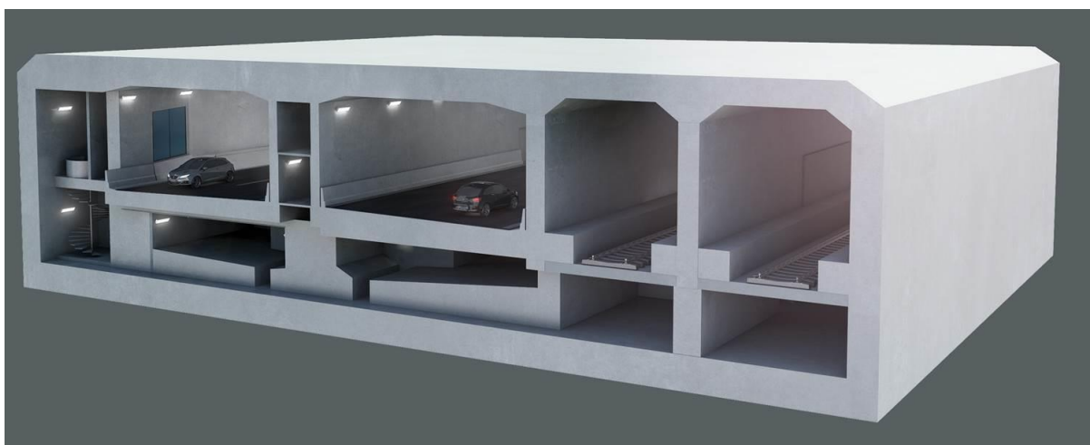
Specialelement til sænketunnelen
