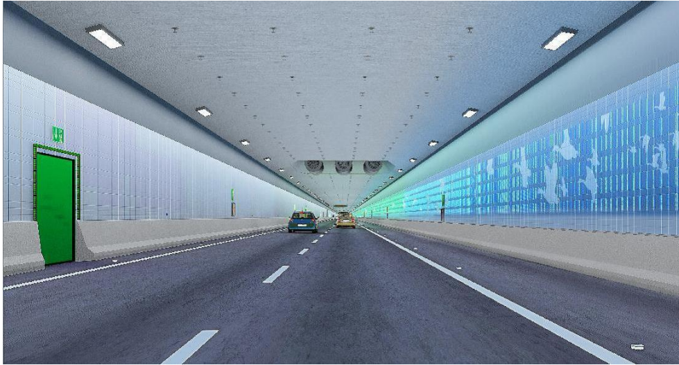
Figur 2, Tegning af det sydgående (ydre) vejtunnelrør. I loftet ses en niche med jefans, der er en del af ventilationssystemet
