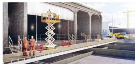
Beim Bau des Fehmarnbelt-Tunnels kommt die bewährte Technologie zum Einsatz, die zuletzt bei der Errichtung der Öresundverbindung zwischen Dänemark und Schweden angewandt wurde. Für den Fehmarnbelt-Tunnel werden 79 Standardelemente produziert, die in den Produktionslinien nach dem Fließbandprinzip hergestellt werden. Hinzu kommen 10 Spezialelemente, die zusätzlich über ein Untergeschoss für Installationen verfügen.
