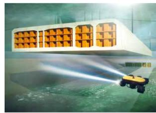
Baggerschiffe heben den 18 Kilometer langen Tunnelgraben am Meeresgrund aus, in den die Tunnelelemente abgesenkt und miteinander verbunden werden. Das ausgehobene Material wird für die Landgewinnung in der Nähe von Rødbjerg und Puttgarden verwendet. Dort entstehen neue Natur- und Erholungsgebiete.
