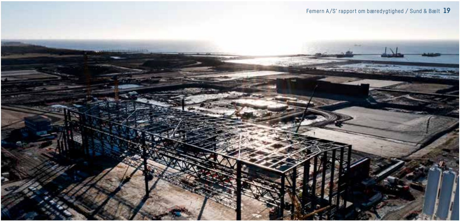
Anlæg af tunnel-elementfabrikken i Rødbyhavn
